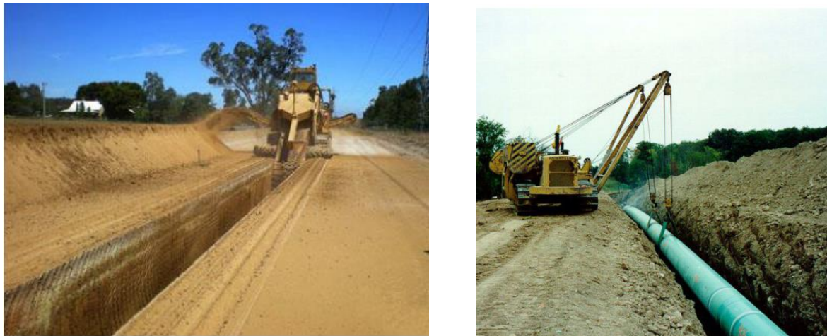
Figura 2.e: Esempi di Scavo e Posa Lungo il Cantiere di un Metanodotto
